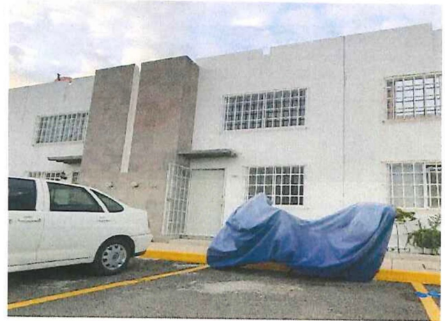
FACHADA DEL INMUEBLE; VOLADO (T2)
